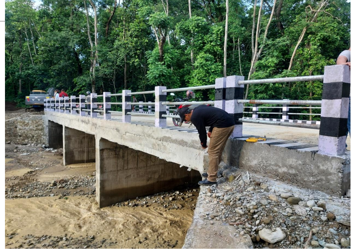
सिमले सफेवा खोलामा मलिट सेल बक्स कल्भर्ट
