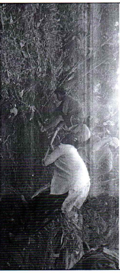
जोगिटारबाट सरस्वती स्कूल आउने बाटो मर्मत, वडा नं ५
